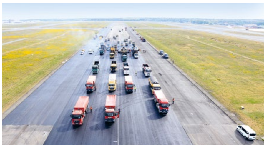
Baustellen am Frankfurter Flughafen sind immer eine logistische Herausforderung – auch für die Mischanlage Kelsterbach, die das Einbaumaterial in der richtigen Menge in den geforderten Qualitäten zur richtigen Zeit anliefern. (Foto: Fraport AG)
