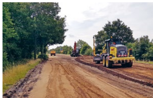
Auf rund neun Kilometern wurde die Strecke grundhaft erneuert und mit einem Grader das Erdplanum profiliert (Foto links). Fünf Walzenzüge im Schlepptau des Einbauzugs sorgen für eine absolut ebene Oberfläche.
