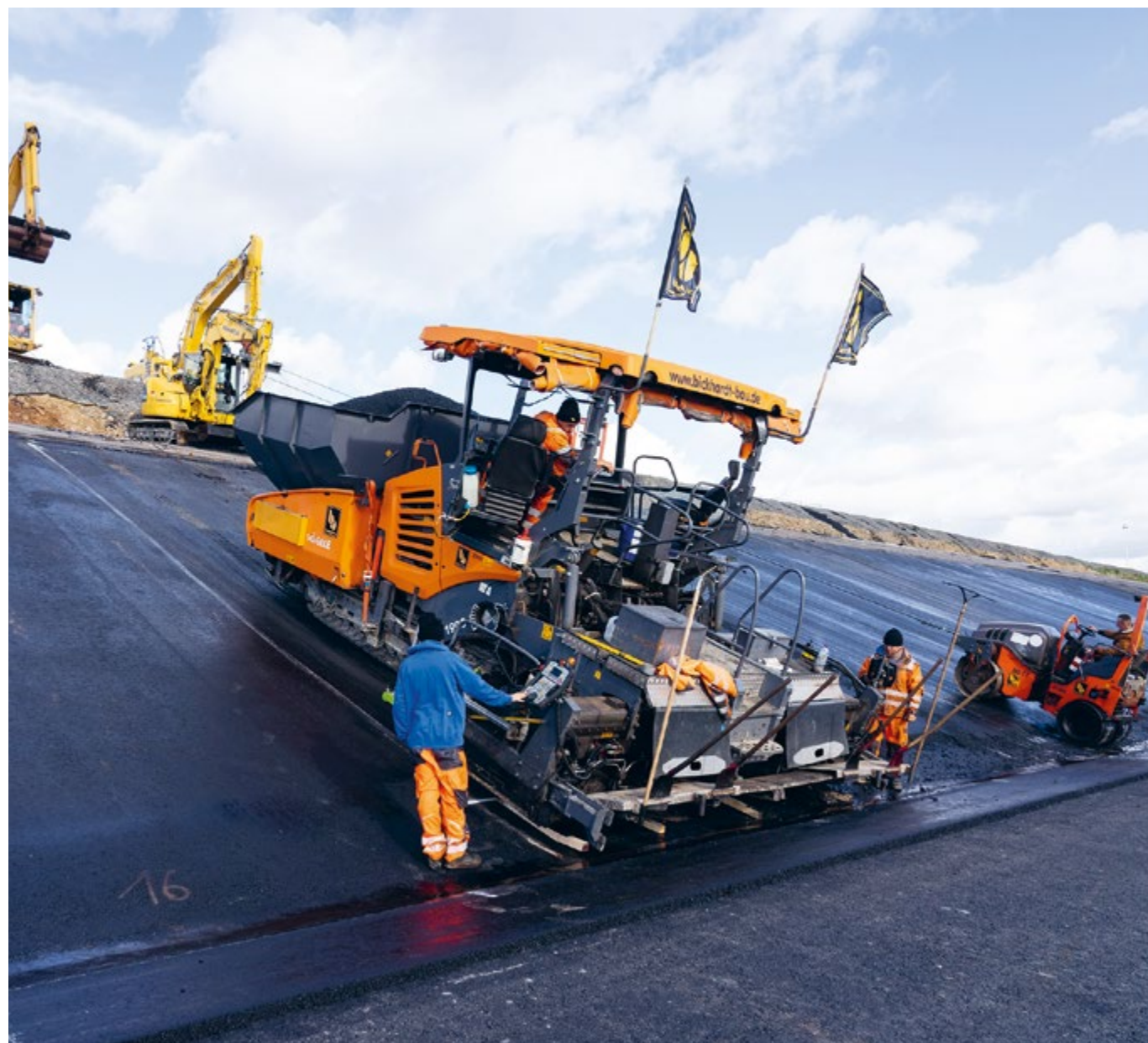
Es geht nach oben: Der Fertiger ist startklar. Eingebaut wird in vertikaler Richtung nach oben. Der Standstreifen der A1 reicht bis an den Böschungsfuß einer alten Mülldeponie heran. Deswegen muss die Abdichtung in diesem Bereich erneuert werden.
