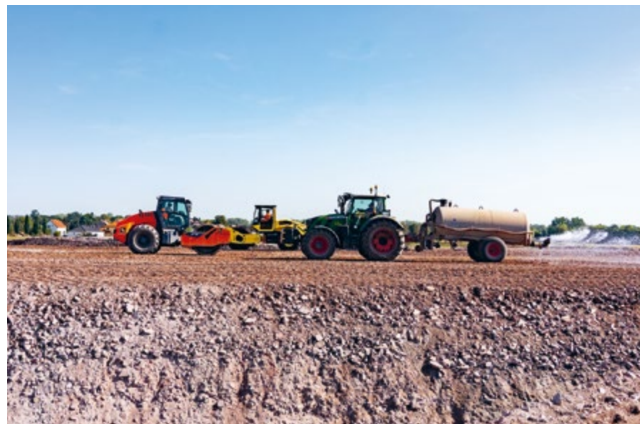
Der Fahrbahndamm im Bereich der neuen Anschlussstelle Wedringen wächst lagenweise in die Höhe. Walzen und die Zugabe von Wasser sorgen für die nötige Verdichtung.
