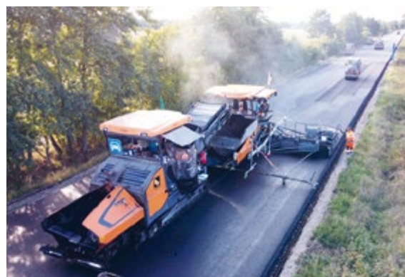
Auf rund neun Kilometern wurde die Strecke grundhaft erneuert und mit einem Grader das Erdplanum profiliert (Foto links). Fünf Walzenzüge im Schlepptau des Einbauzugs sorgen für eine absolut ebene Oberfläche.
