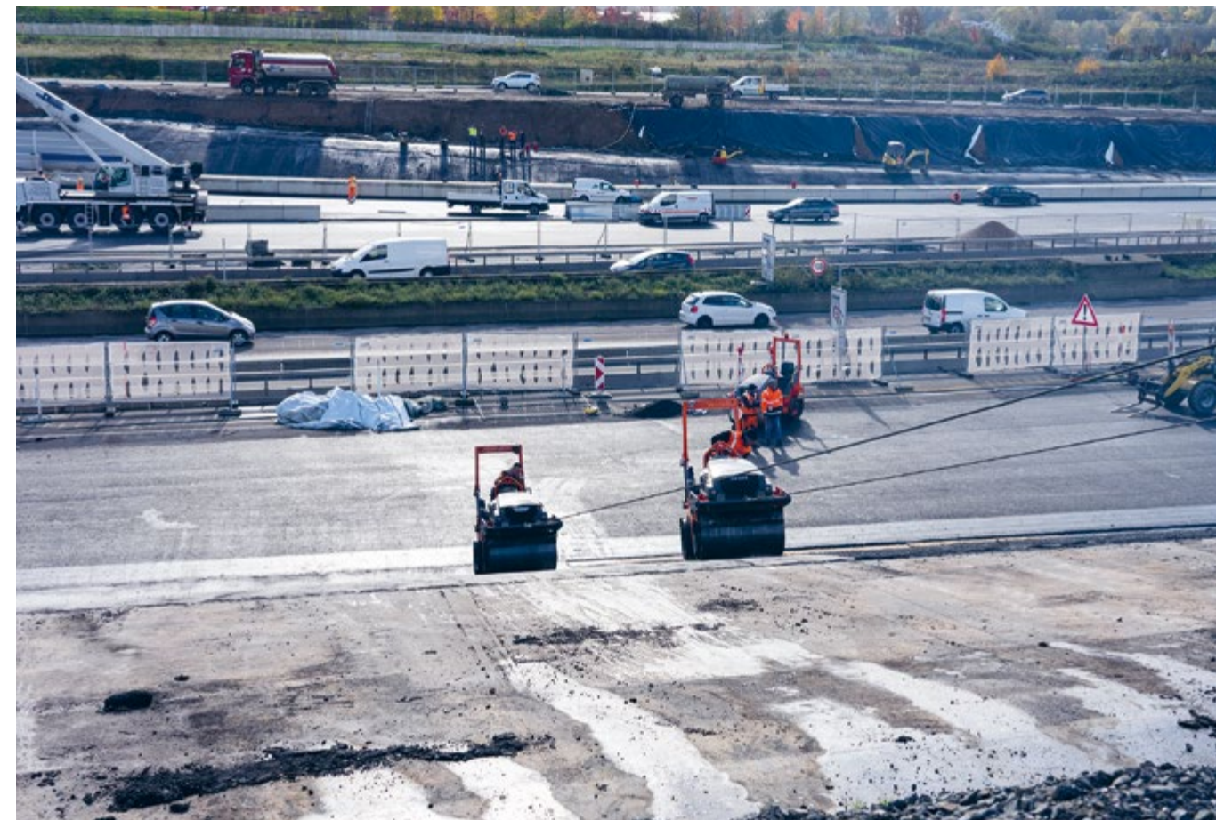
Auf Spannung gehalten: Die beiden Kombiwalzen fahren abwechselnd im Pendelverkehr die Böschung hinauf. Am Fuß beginnt der Standstreifen der A1 in Fahrtrichtung der Leverkusener Rheinbrücke.
