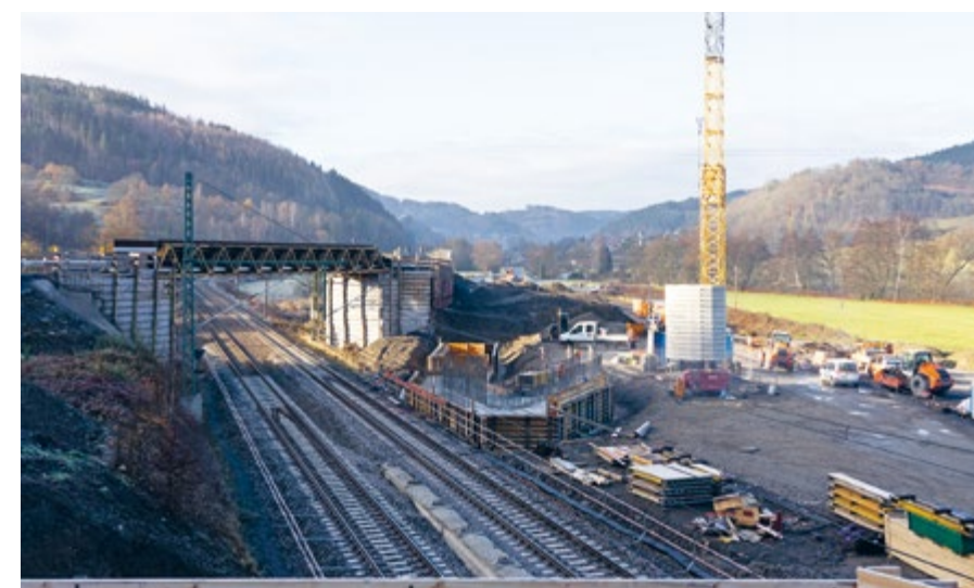
Blick auf das neue Widerlager. Zwischen den Gleisen sind noch Reste der alten Pfeilerkonstruktion zu erkennen. Sie werden noch zurückgebaut.
