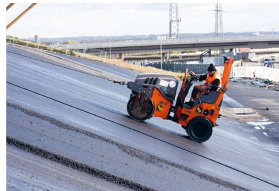
Eine der beiden Kombiwalzen, die im Pendeltakt auf und ab rollen und sich so gegenseitig hochziehen.
