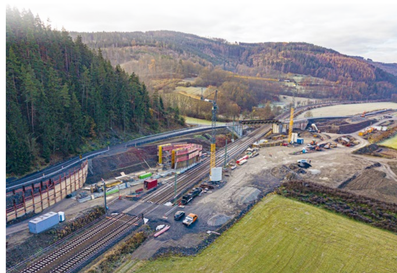
Umfahrung, Behelfsbrücke, Widerlager des Brückenneubaus, Baukrane, Container-Camp und Bahnlinie liegen am Kreuzungsbereich mit der B85 bei Hockeroda auf engstem Raum beieinander. Entsprechend komplex ist das Bauvorhaben, bei dem die Vorzüge des Komplettanbieters Bickhardt Bau zum Tragen kommen.
