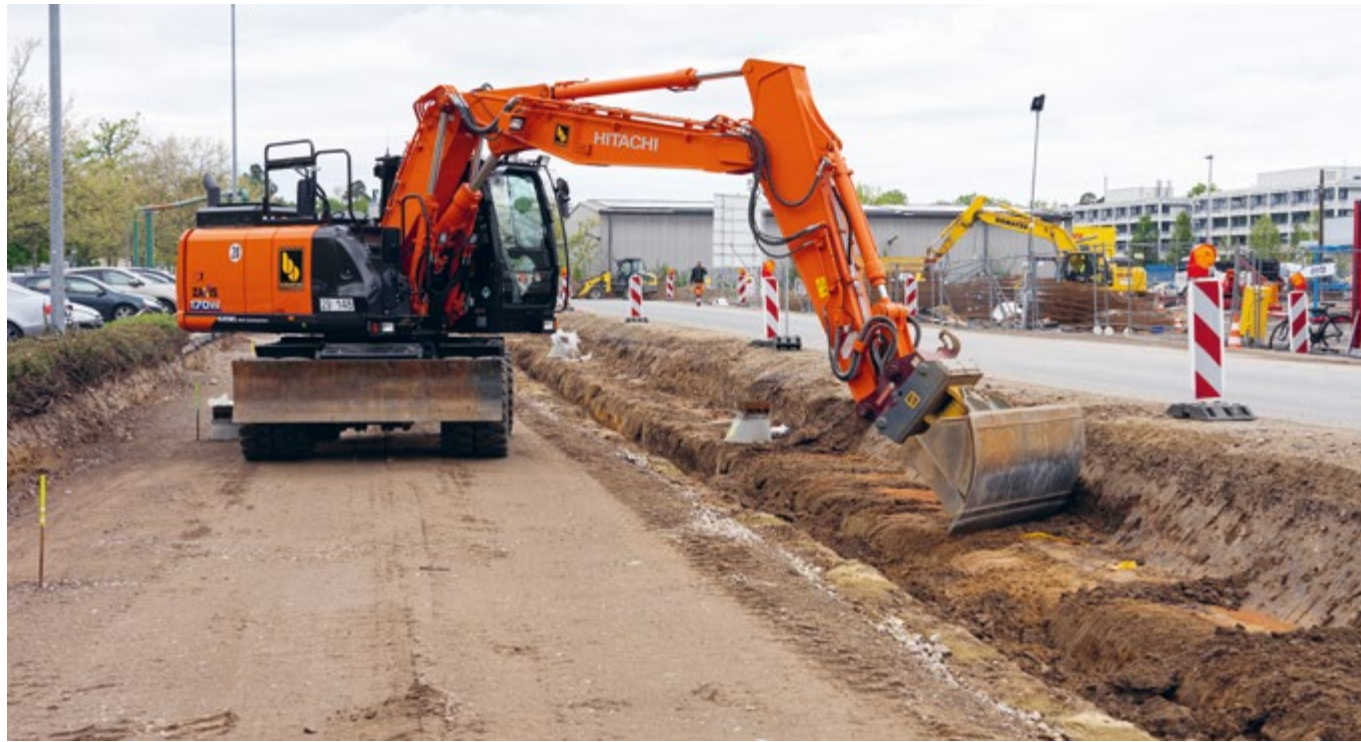
Innerstädtische Erschließung im Technologiepark Hanau-Wolfgang: Um die Hauptverkehrsachse Marie-Curie-Straße grundhaft zu erneuern, musste zunächst eine Behelfsstraße (rechts zwischen den Warnbaken) angelegt werden. Sie wird nach dem Straßen- ausbau wieder zurückgebaut.
