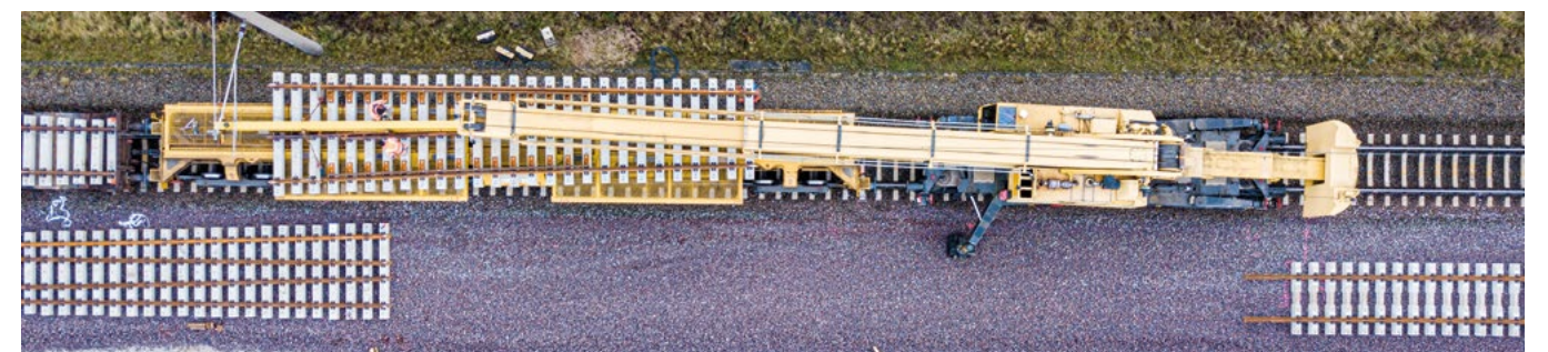
Ungewöhnliche Perspektive: Der Einbau einer Weiche aus der Vogelperspektive. Vom Parallelgleis aus hebt der Kirow-Gleiskran von Hartung Bau die vorgefertigten Weichenteile ein.
