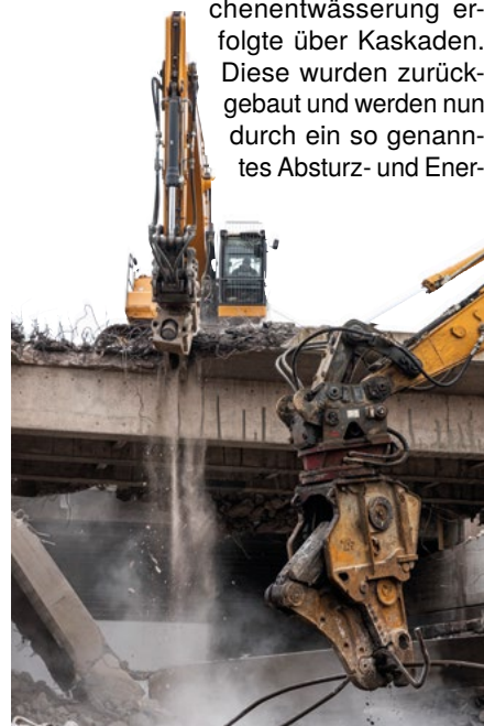
Kraftvoll: Gegen die hydraulischen Greifzangen kommt keine Brücke an.
