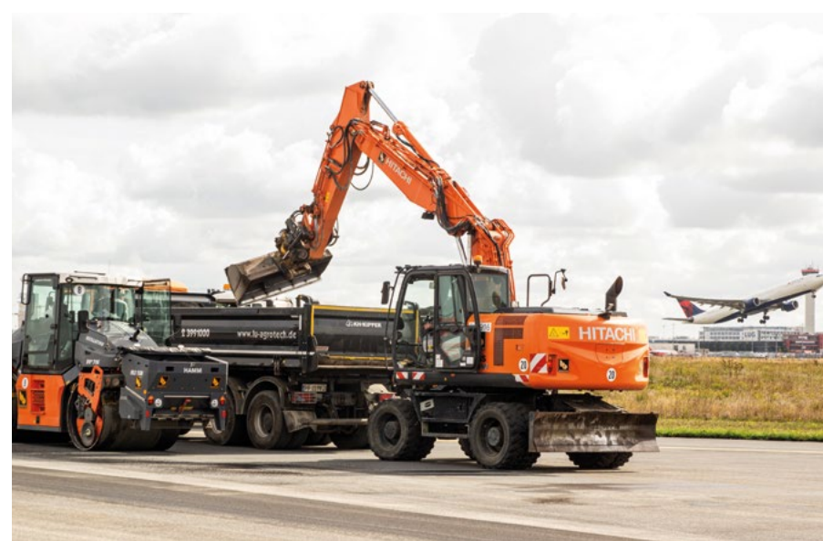
Action auch am Rand der neuen Landebahn: Die Splittbunker der Walzen werden mit einem Bagger aufgefüllt. Neben an startet ein Flieger.
