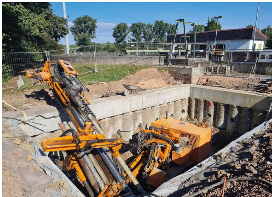
Bohrpfahlarbeiten für die wasserdichte Baugrube (Foto links), die dann zu einem Keller für ein Maschinenhaus ausgebaut wurde. Die Bohrpfahlwand wurde mit einem Kopfbalken versehen, bevor mit dem Ankerbohrgerät die Rückverankerung hergestellt wurde.
