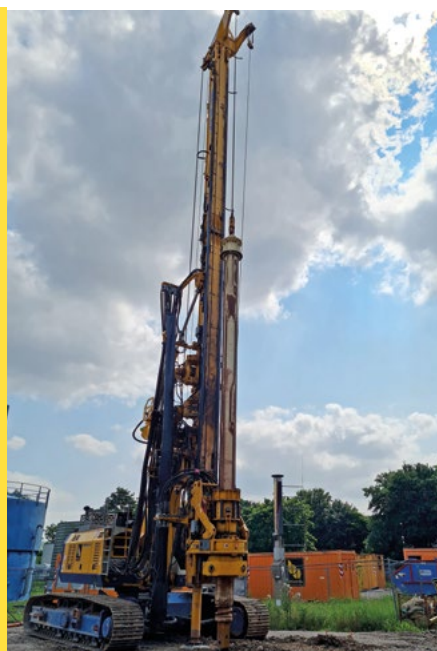
Bohrpfahlarbeiten für die wasserdichte Baugrube (Foto links), die dann zu einem Keller für ein Maschinenhaus ausgebaut wurde. Die Bohrpfahlwand wurde mit einem Kopfbalken versehen, bevor mit dem Ankerbohrgerät die Rückverankerung hergestellt wurde.
