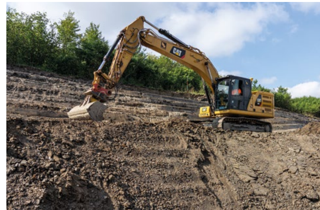
In einigen Streckenabschnitten musste die Böschung aufwendig saniert werden. Die Hangbereiche wurden dort terrassiert.
