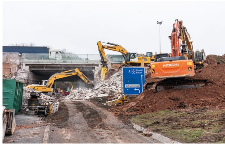
Mächtig Betrieb: Eine Woche wurde der Autobahzubringer Richtung Nord in Kirchheim gesperrt. In dieser Zeit erfolgte der erste Teilabbruch der Autobahnbrücke über die Schwimmbadstraße.
