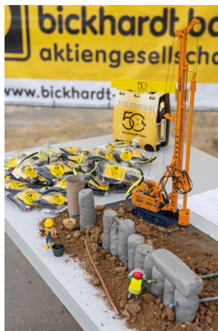
Große Maschinen ganz klein: Zur Veranschaulichung der Baugrubenerstellung im Pilgerschrittverfahren wurde dieses Modell handgefertigt.
