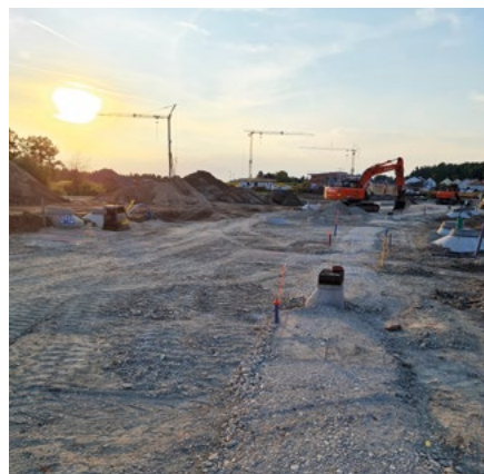
Am Ende eines sonnigen Tages: Die Hausanschlüsse sind gelegt, die Zisternen gesetzt.
