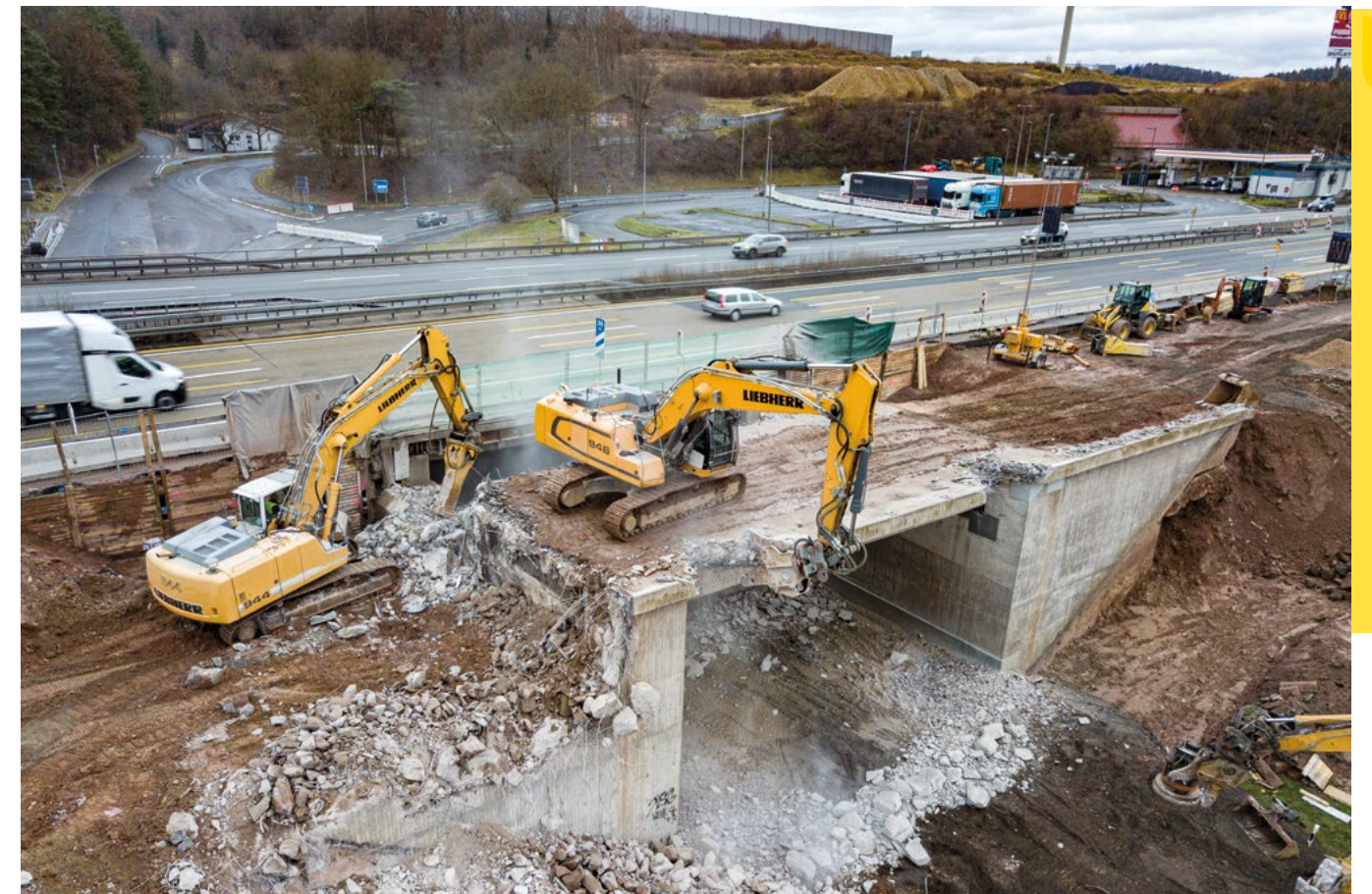
Erst Abriss, dann Neubau: Im Zuge des Umbaus des Kirchheimer Dreiecks wird die Brücke über die Schwimmbadstraße erneuert. Den hydraulischen Greifzangen der Abrissbagger ist kein Überbau gewachsen.
