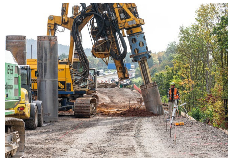
In Schräglage: Für die Gründung der Stützwand wurden Bohrpfähle mit schwerem Gerät im 15-Grad-Winkel hergestellt.
