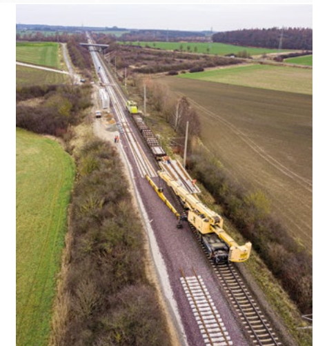
An der Strecke: links neu, rechts Bestand.
