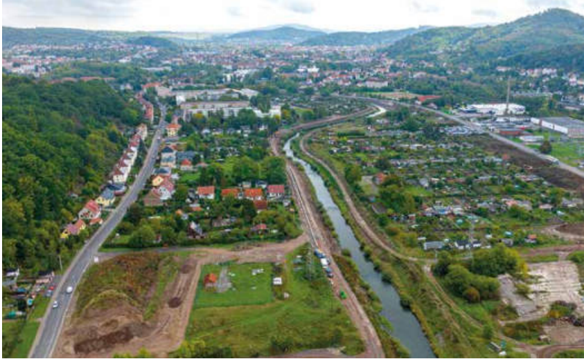
Blick auf den zweiten Bauabschnitt mit den Kleingartenanlagen auf beiden Seiten des Flusses.
