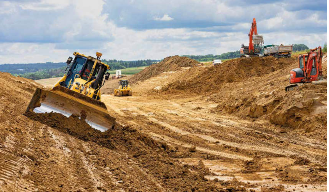
2.000 Meter, die es in sich haben: Beim Bau der Ortsumgehung L 335 Miehlen mussten rund 350.000 Tonnen Boden gelöst, geladen und zum Teil wieder eingebaut werden. Die neue Strecke verläuft in einem Einschnitt. In diesem Frühjahr erfolgt der Einbau der Asphaltsschichten.
