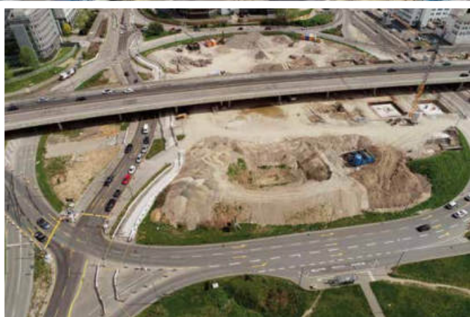
Neue Verkehrsführung am Kaiserlei: Aus dem ehemals größten Kreisverkehr Europas ( links Aufnahme aus der ersten Bauphase 2017 ) ist ein kleines Oval geworden ( großes Foto ). Zwei neu gebaute Rampen binden jetzt den überörtlichen Verkehr an. (Beide Aufnahmen: Georg-Foto Offenbach)
