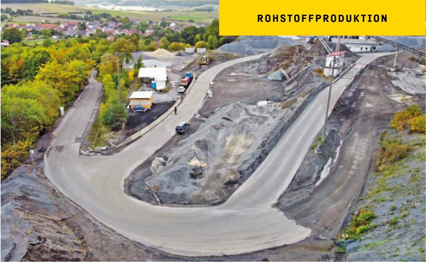
Über die neue Werkstraße zur Asphaltmischanlage – im Basaltwerk Großropperhausen wurde eine Ringstraße asphaltiert.
