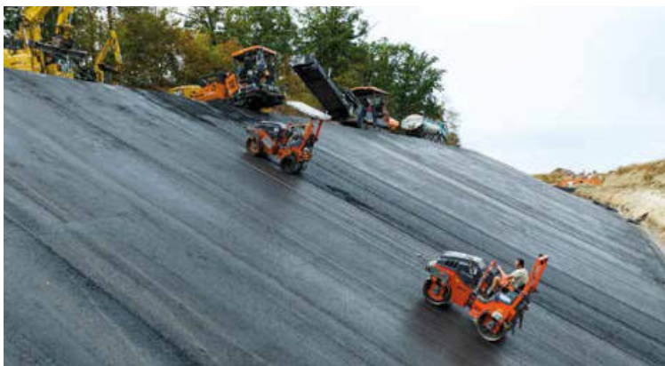
Übersichtsfoto (oben) der Oberflächenabdichtung der Erweiterungsflächen für die Deponie Hamberg, nördlich von Maulbronn. Die Aufnahme entstand beim Einbau der Deckschicht auf die Tragschicht. Ganz links im Bild ist bereits die Entwässerungsschicht aus Schotter aufgebracht worden. Erst die Schrägperspektive (kleines Foto links) verdeutlicht wie steil es bei einem Böschungswinkel von 1:2 zur Sache geht. Detailaufnahme des Hakens, an dem die ganze Maschinenteknik hängt. Pink ist dabei keineswegs eine willkürlich ausgewählte Modefarbe, sondern kennzeichnet die Belastungsklasse des Schekels.
