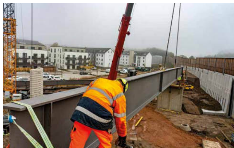
Landmarke am Rande des Pioneer Parks: Für eine Geh- und Radwegbrücke werden die Fertigteile eingehoben und zunächst fixiert.
