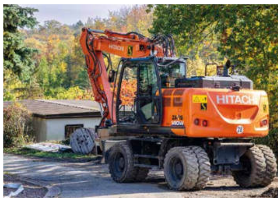
Der Ausbau in den beengten Verhältnissen erfolgt vor Kopf.
