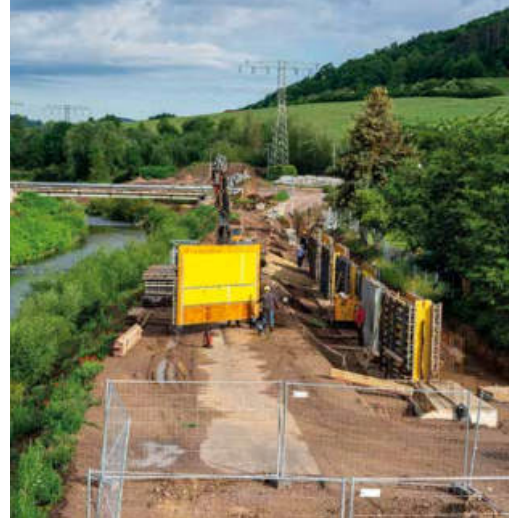
Die Schalungselemente für die Hochwasserschutzmauer im zweiten Bauabschnitt werden gestellt.
