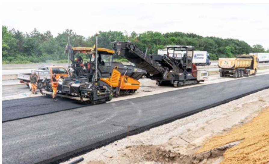
Asphaltierung der neuen Anschlussstelle Zeppelinheim an der A5. Der Einbau der Asphalt-schichten erfolgte absteckungsfrei mit vollautomatischer 3-D-Steuerung.
