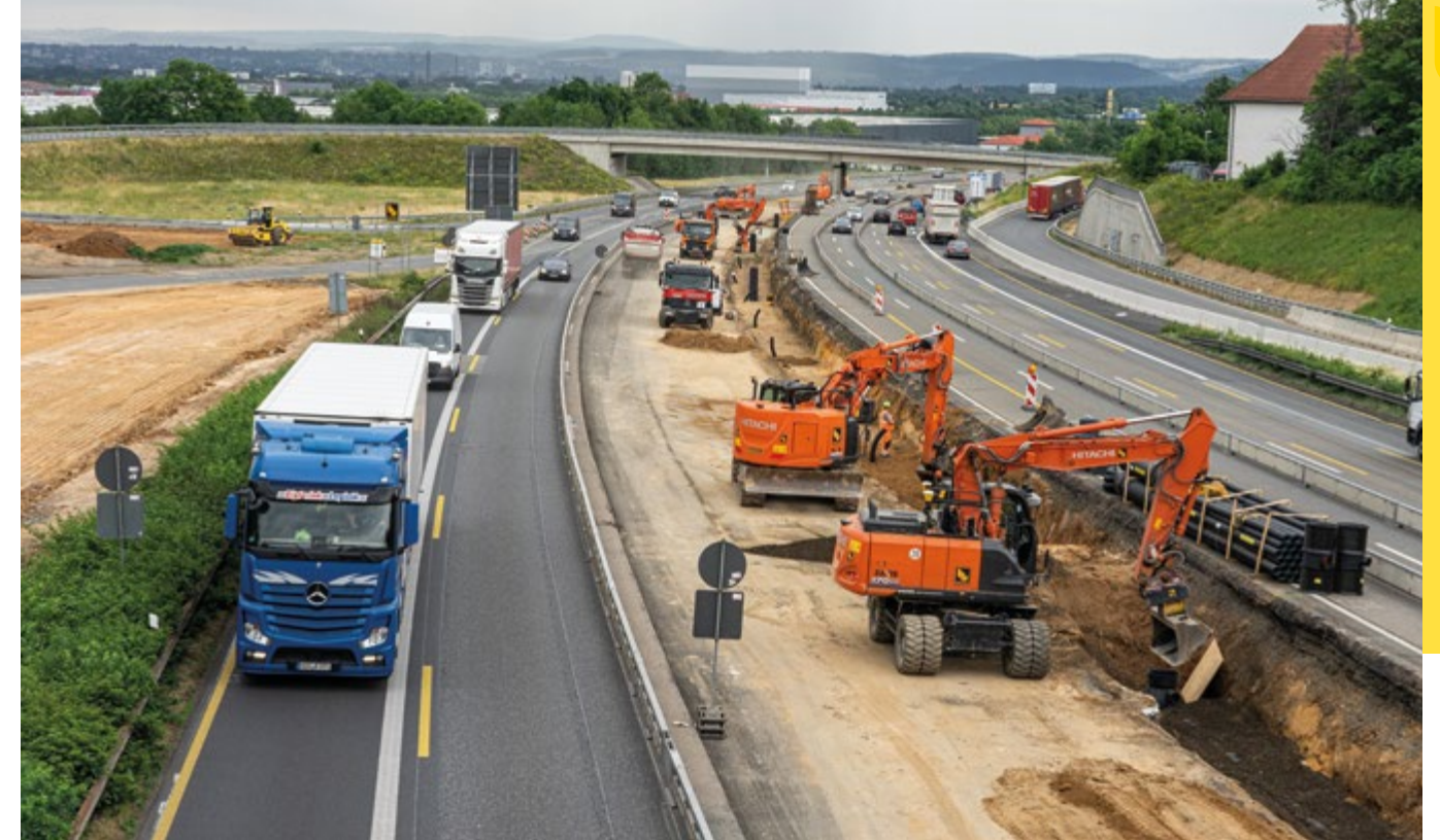
Geballte Maschinenpower: Fünf Mobil- und Kurzheckbagger waren auf der A7 bei Kassel gleichzeitig im Einsatz, um die Mittelstreifenentwässerung zu erneuern.
