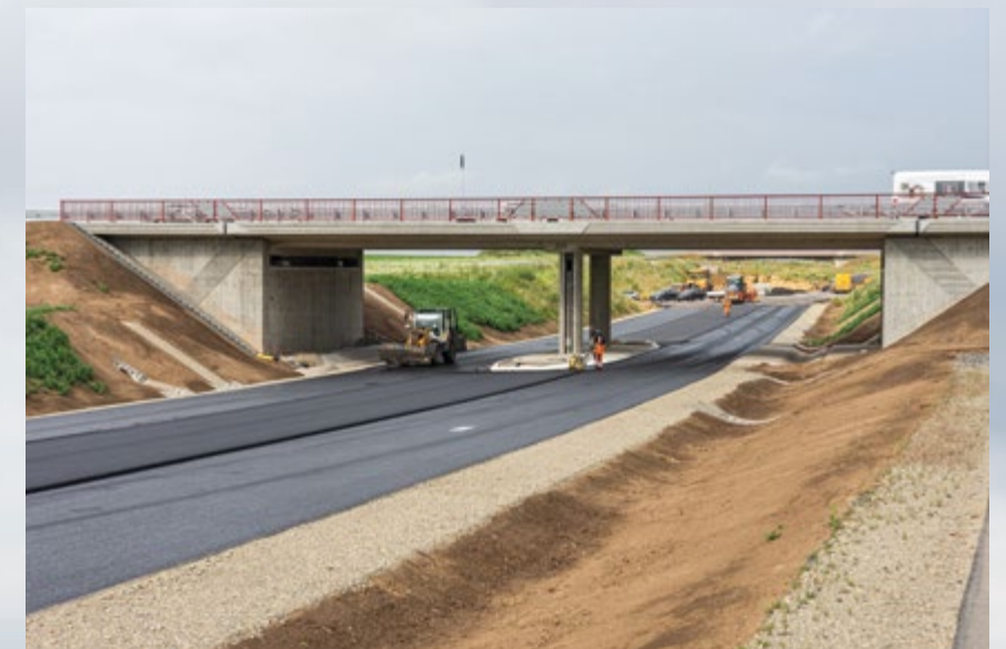
Die neue Überführung der B83 über die K47n. Die Abteilung Brücken- und Ingenieurbau hat das Zweifeld-Bauwerk hergestellt. Während der Bauzeit wurde der Verkehr über die späteren Zu- und Abfahrtsrampen umgeleitet. Ende Juni wurde asphaltiert.
