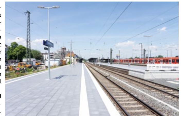
Der Hausbahnsteig 1 am Bahnhof Friedberg wurde bereits in der ersten Bauphase fertig gestellt.
