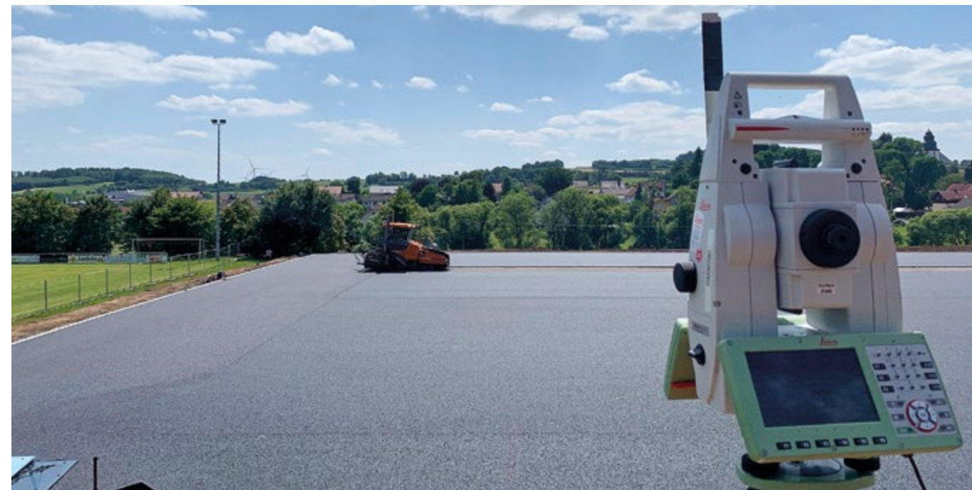
Höchste Präzision und Ebenheit: Der absteckungsfreie Einbau des Dränasphalts am Sportplatz Freiensteinau. Die Einbaumethode hat sich bei diesem Einsatzgebiet bewährt.
