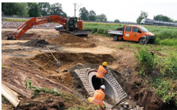
Mehrere Durchlässe queren den Bahndamm. Die Öffnungen wurden mit Natursteinen geflüstert.
