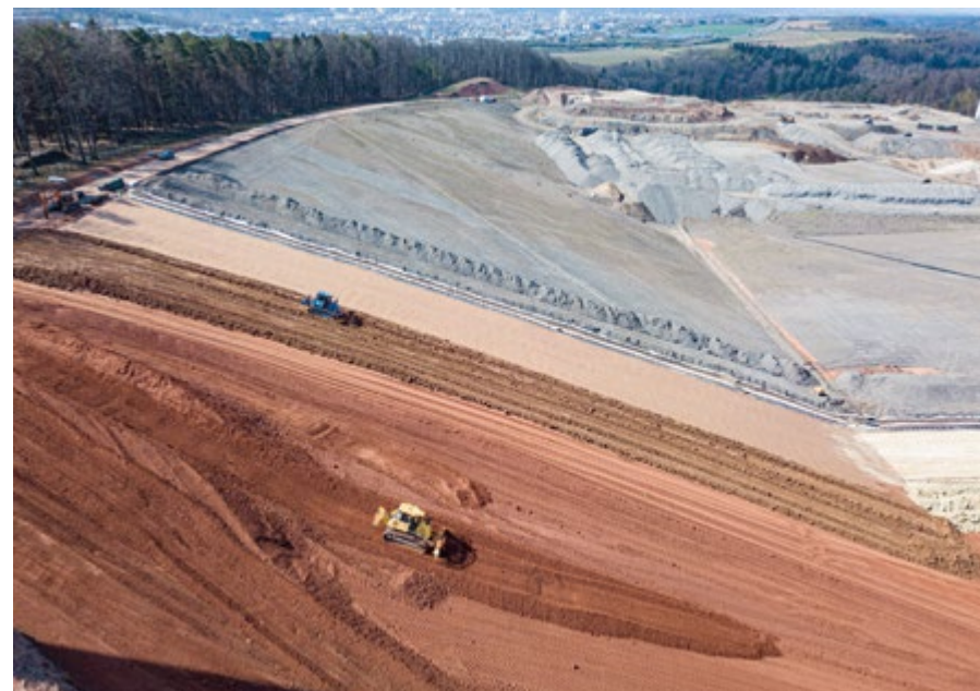
Vor den Toren der Stadt Kaiserslautern wird Platz für neue Deponieflächen geschaffen und zwar durch eine Deponie auf der Deponie. Bevor der Müll gelagert werden kann, muss erst die Abdichtung hergestellt werden. Die verschiedenen Bodenqualitäten, die dafür eingebaut werden, sind gut an ihrer unterschiedlichen Färbung zu erkennen. Am Horizont ist die Bebauung der Pfälzer Metropole ebenfalls gut zu sehen.
