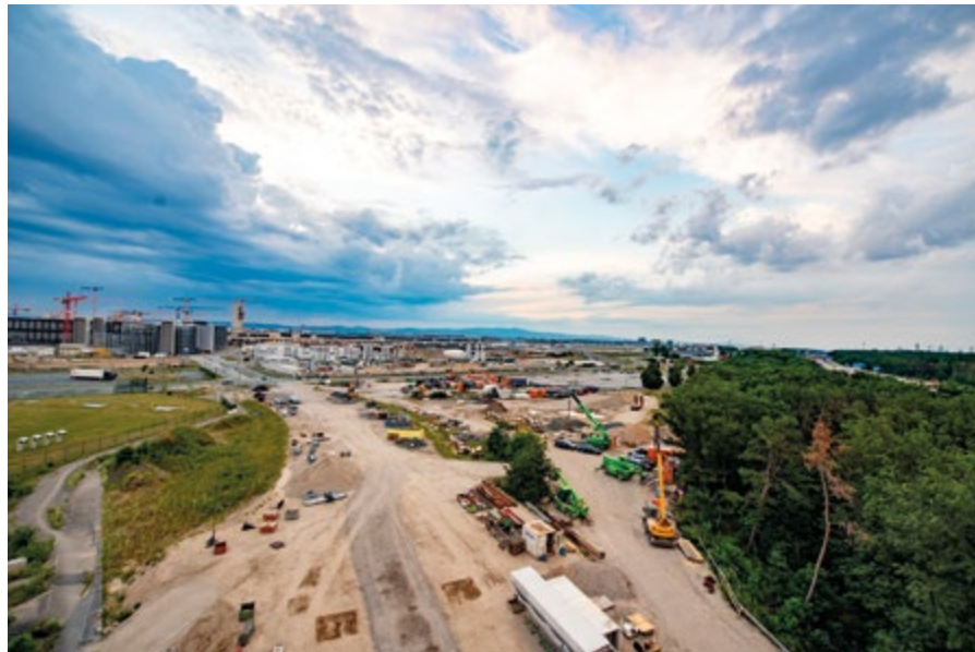
Blick über das Baucamp in Richtung Flughafen mit dem Terminal 3 auf der linken Seite. Bei den Kränen (links) wird das neue Parkhaus gebaut. Für die Erschließungsarbeiten war die Bickhardt Bau Niederlassung Fulda zuständig.
