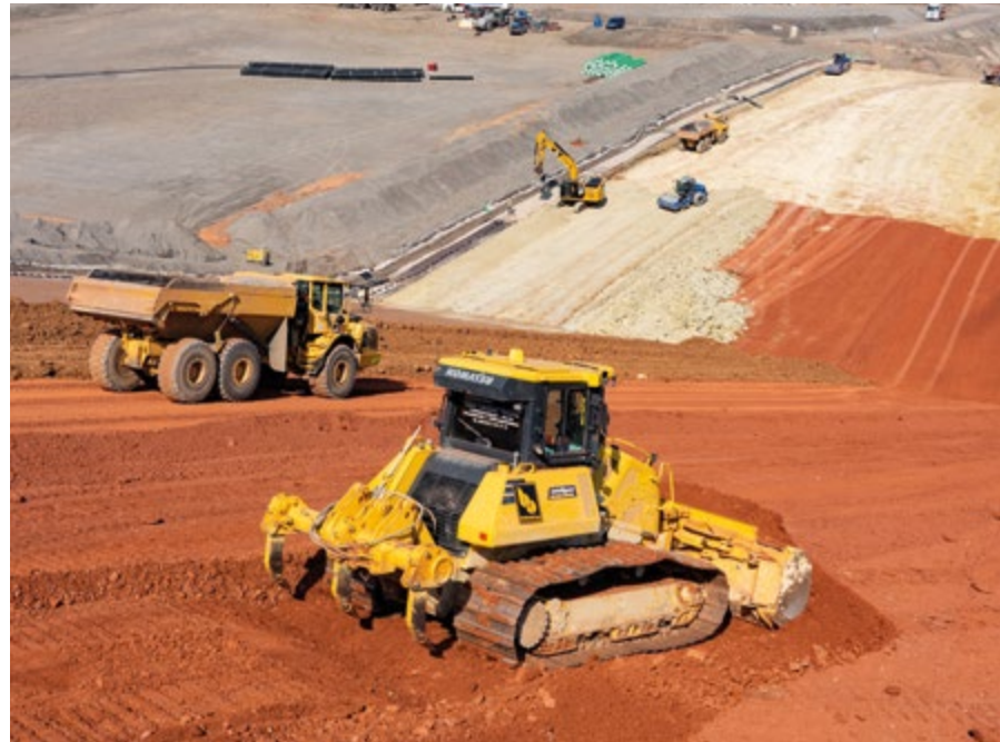
130 Meter ist die Böschung von der Oberkante bis zum Fuß lang. Mit einer Neigung von 1:3 geht es ganz schön steil bergab – für die Raupe und den Dumper ist diese Steigung allerdings kein Problem.
