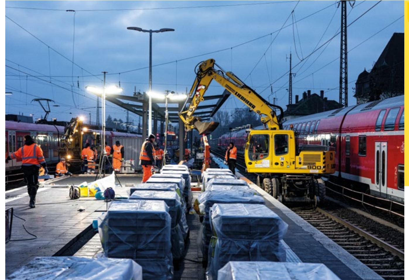
Modernisierung des Bahnhofs Friedberg: Bei dem Umbau der Bahnsteige wurde auch nachts gearbeitet.
