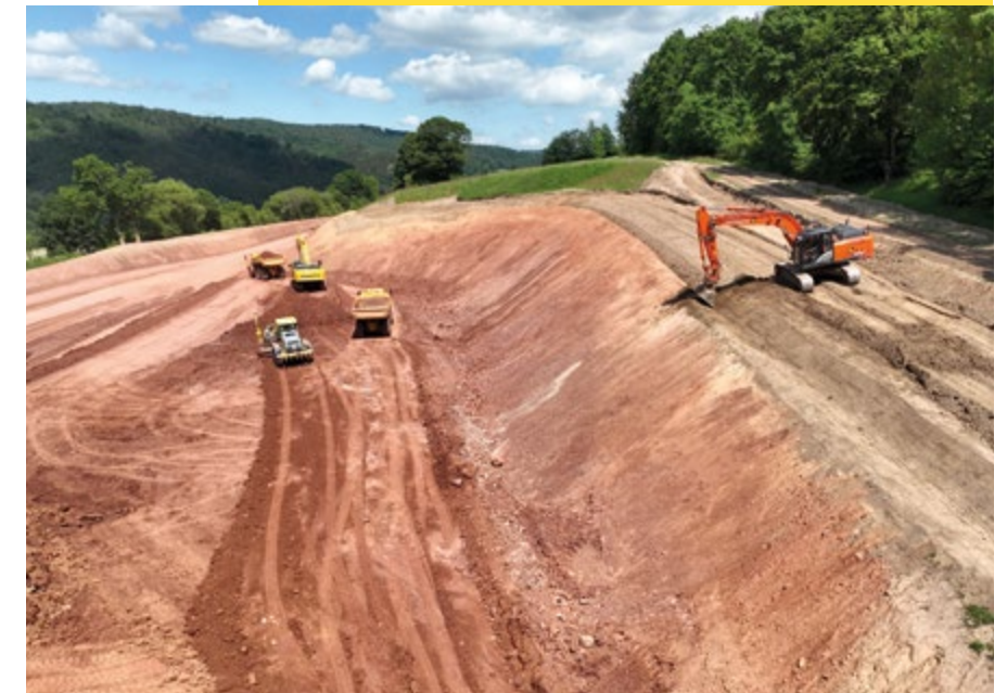
Erdbau mit schwerem Gerät: Im Bereich der späteren Anschlussstelle Bollensen (oben) wird Boden abgetragen und in den Auftragsbereichen der Straßendämme (links) wieder qualifiziert eingebaut. Blick auf das bisherige Ausbauende (rechts), wo der Bauabschnitt anschließt. Dort verläuft die Strecke auf ca. 800 Metern Länge dreispurig.
