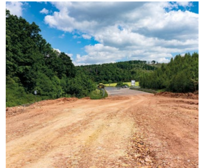
Erdbau mit schwerem Gerät: Im Bereich der späteren Anschlussstelle Bollensen (oben) wird Boden abgetragen und in den Auftragsbereichen der Straßendämme (links) wieder qualifiziert eingebaut. Blick auf das bisherige Ausbauende (rechts), wo der Bauabschnitt anschließt. Dort verläuft die Strecke auf ca. 800 Metern Länge dreispurig.
