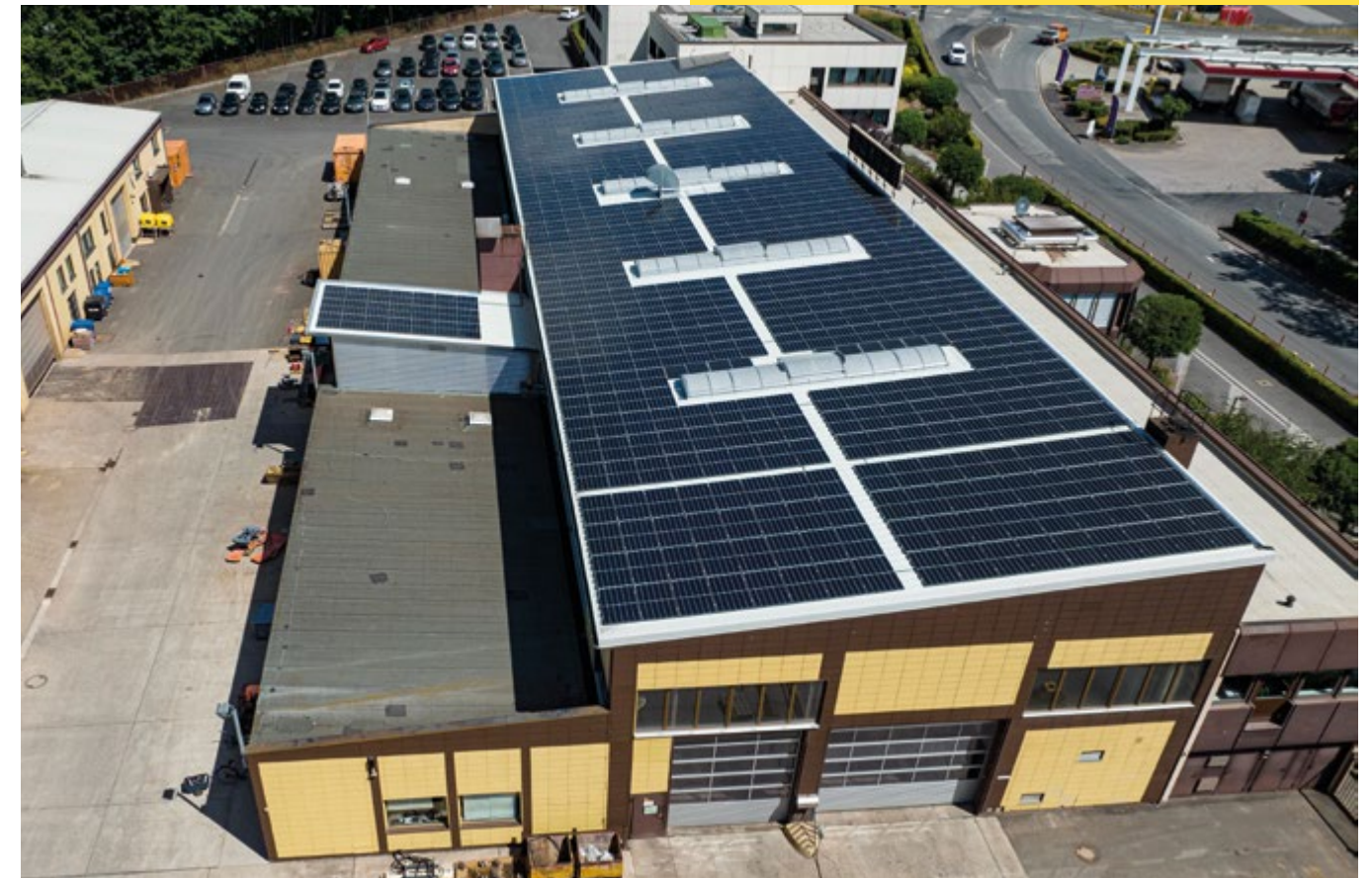
Auf den Dachflächen der Werkstatt am Hauptsitz in Kirchheim ist eine Photovoltaikanlage installiert worden. Dort wird jetzt Strom für den Eigenverbrauch produziert. Auch weitere Hallendächer auf dem Grundstück sind mit Solarmodulen belegt worden. Die 500 kWp Anlage könnte 125 Vier-Personen-Haushalte ein Jahr lang mit Strom versorgen.
