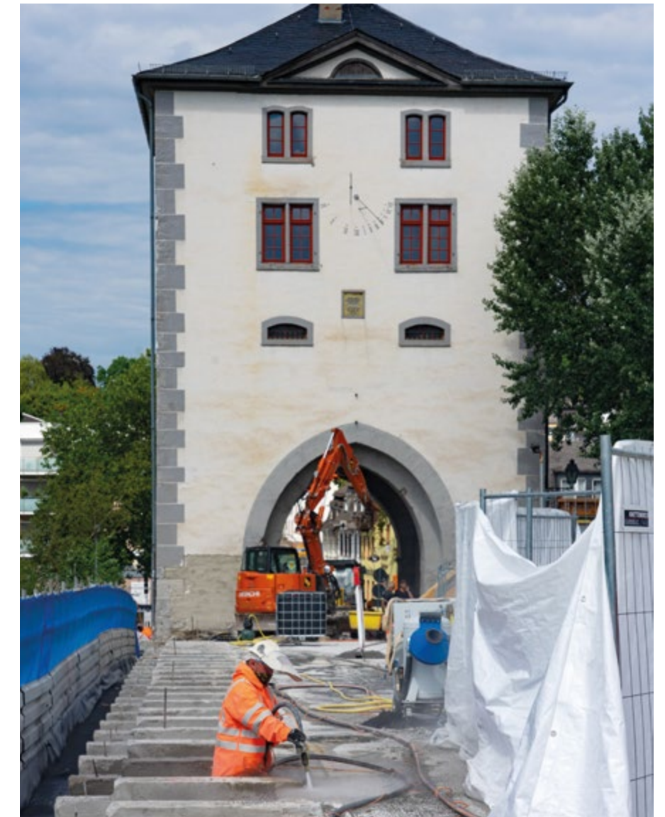
Minibagger vor historischem Bauwerk: Bei der Sanierung der alten Lahnbrücke in Limburg wurden die Kappen zurückgebaut sowie die Kragarme freigelegt und gesandstrahlt.
