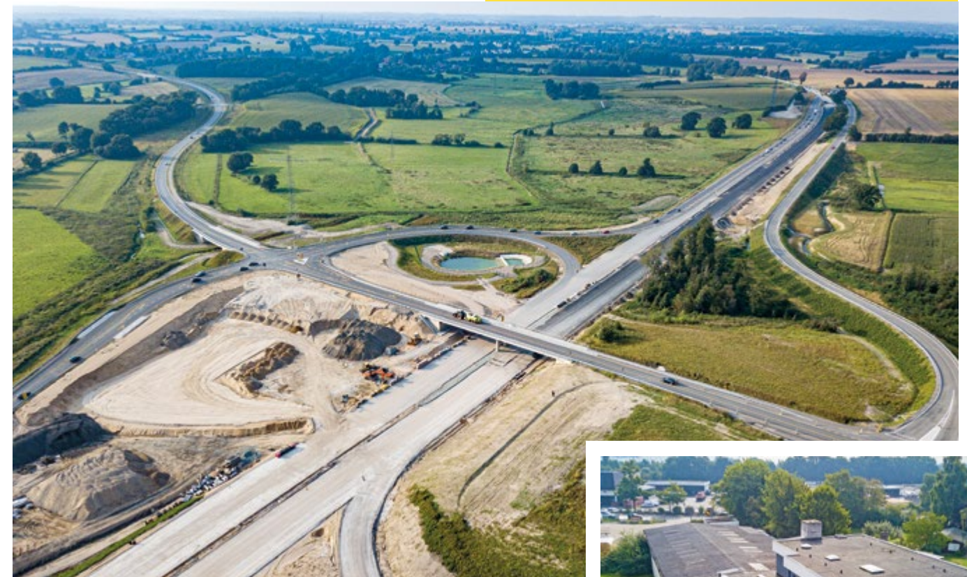
Und immer wieder die A 21: Der Ausbau der Bundesstraße 404 zur Autobahn 21 ist offenbar eng mit der erfolgreichen Entwicklung der Niederlassung Lübeck verknüpft. Mehrere Bauabschnitte wurden dort bislang hergestellt. Unser Bild oben zeigt die Anschlussstelle Nettelsee. Foto rechts: Die Niederlassung an der Sierksdorfer Straße in Neustadt in Holstein.
