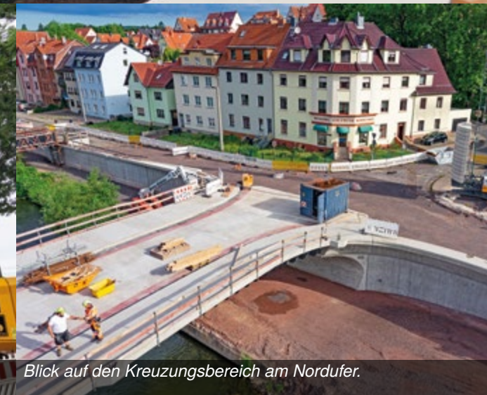
Gründungsarbeiten durch die Abteilung Spezialtiefbau.
