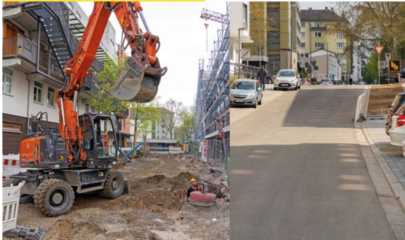
In vier Bauabschnitten haben die Mitarbeiter der Niederlassung Rheinland-Pfalz die Wallaustraße in Mainz grundhaft erneuert und gleichzeitig den Straßenraum anspruchsvoll ausgebaut. Das Foto rechts oben zeigt den ersten fertig gestellten Straßenbereich.
