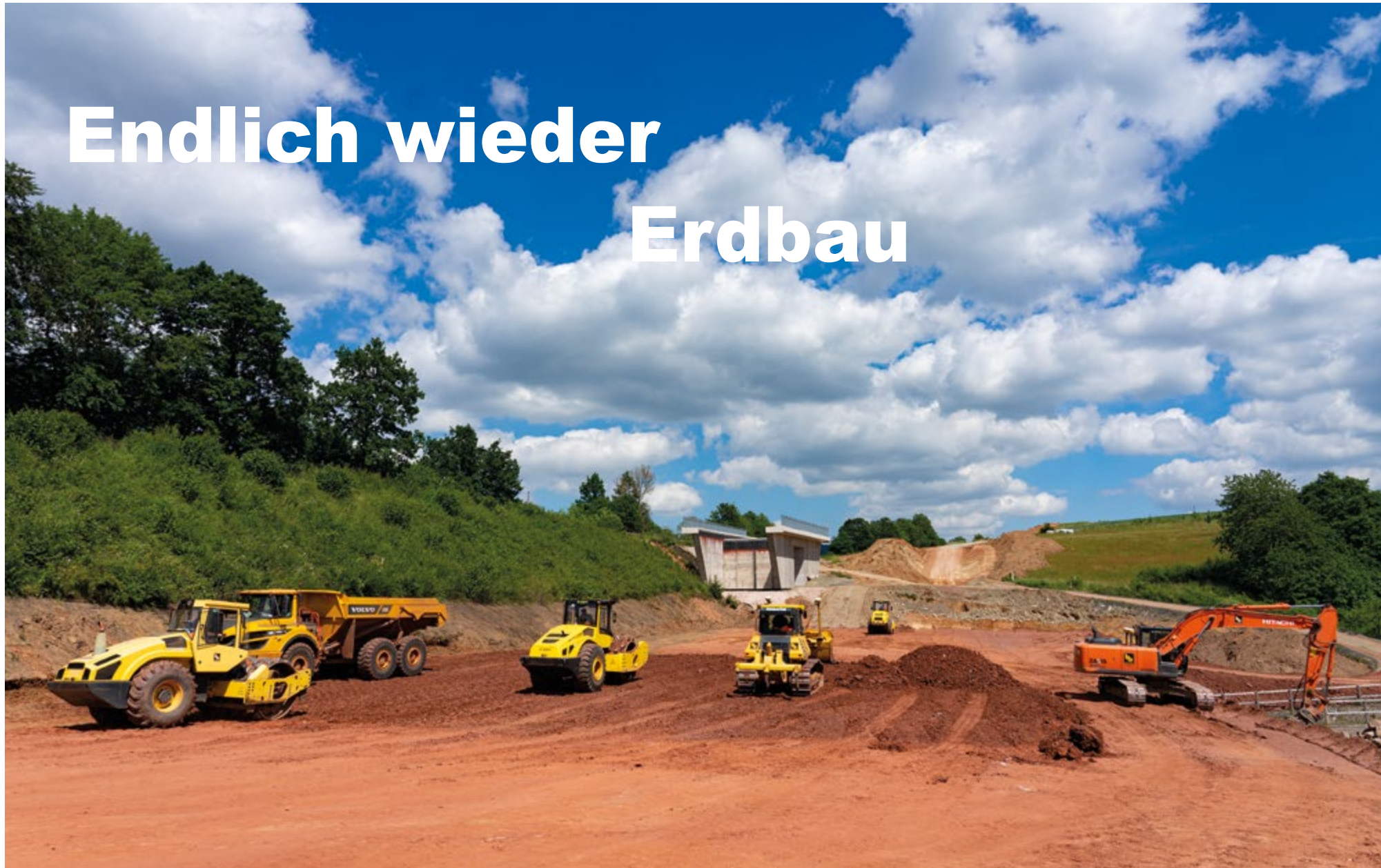
Erdbau mit schwerem Gerät: Im Bereich der späteren Anschlussstelle Bollensen (oben) wird Boden abgetragen und in den Auftragsbereichen der Straßendämme (links) wieder qualifiziert eingebaut. Blick auf das bisherige Ausbauende (rechts), wo der Bauabschnitt anschließt. Dort verläuft die Strecke auf ca. 800 Metern Länge dreispurig.
