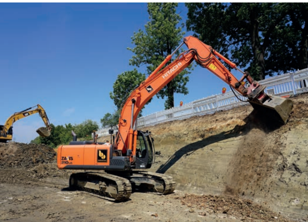
Bodenaustausch: Die Tonschichten unter dem Fahrbahndamm der B 454 mussten ausgekoffert werden.
