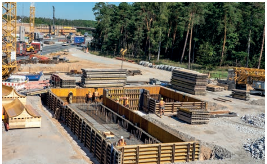
Blick von Süden in Richtung Norden: Neben der Bestandsbrücke (Brückengeländer Foto links) werden die Fundamente für das neue Bauwerk Süd geschalt und bewehrt.
