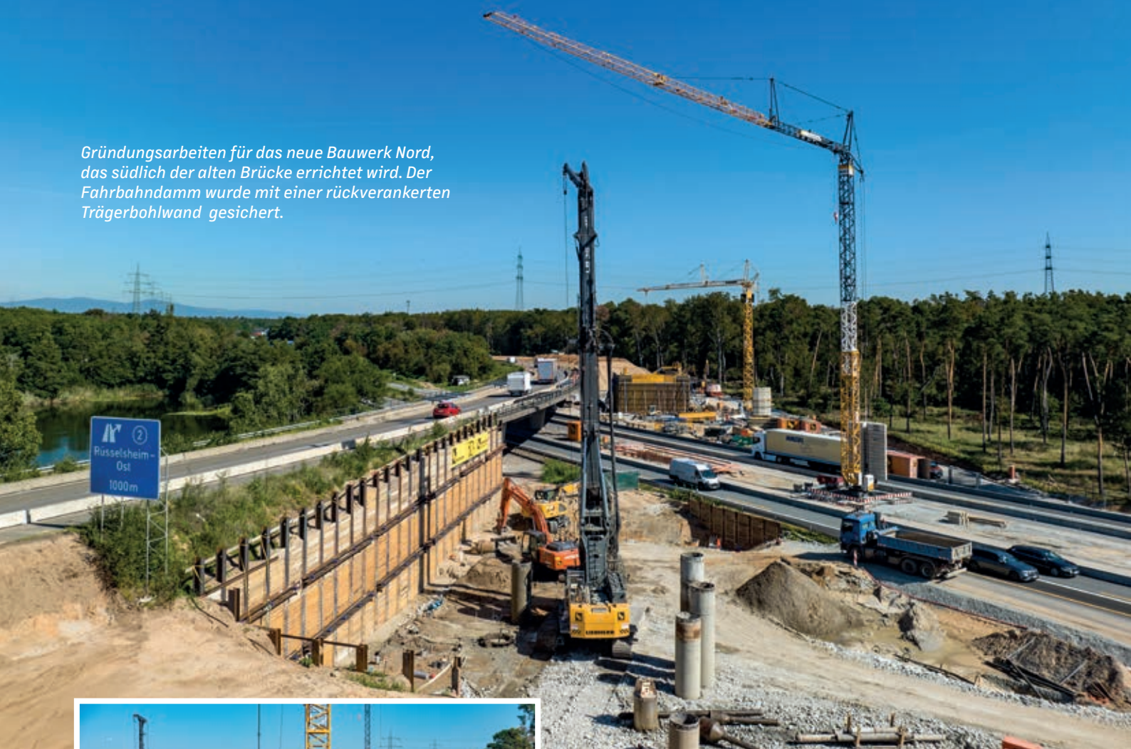
Inselbaustelle mit Kränen (kleines Foto): Im Mittelstreifen der A 67 werden die neuen Pfeiler hergestellt. Der Verkehr fließt rechts und links davon weiter.
