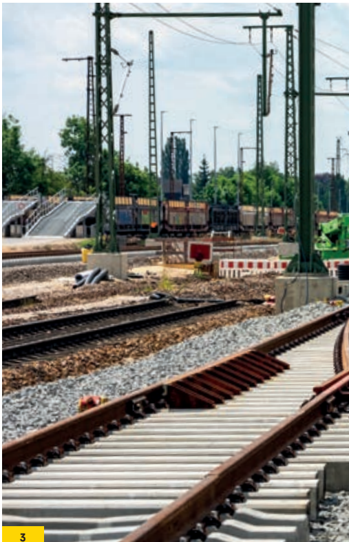
3: Weichenstellung: Im Zuge des Ausbaus des Bahnknotens Göbnitz müssen insgesamt 40 Weichen neu verlegt werden.
