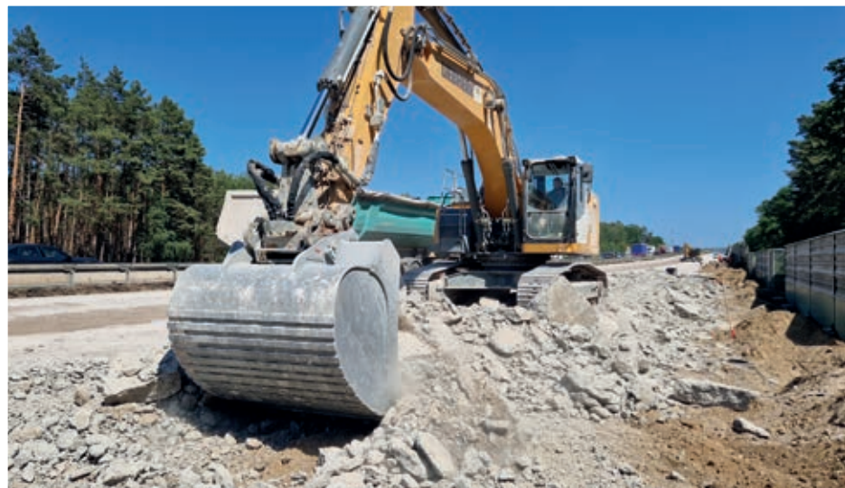
Unten: Der Betonaufbruch wurde mit großen Baggern auf Sattelzüge geladen und abtransportiert.
