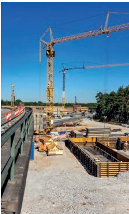
Blick von Süden in Richtung Norden: Neben der Bestandsbrücke (Brückengeländer Foto links) werden die Fundamente für das neue Bauwerk Süd geschalt und bewehrt.
