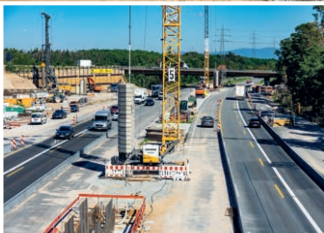
Inselbaustelle mit Kränen (kleines Foto): Im Mittelstreifen der A 67 werden die neuen Pfeiler hergestellt. Der Verkehr fließt rechts und links davon weiter.
