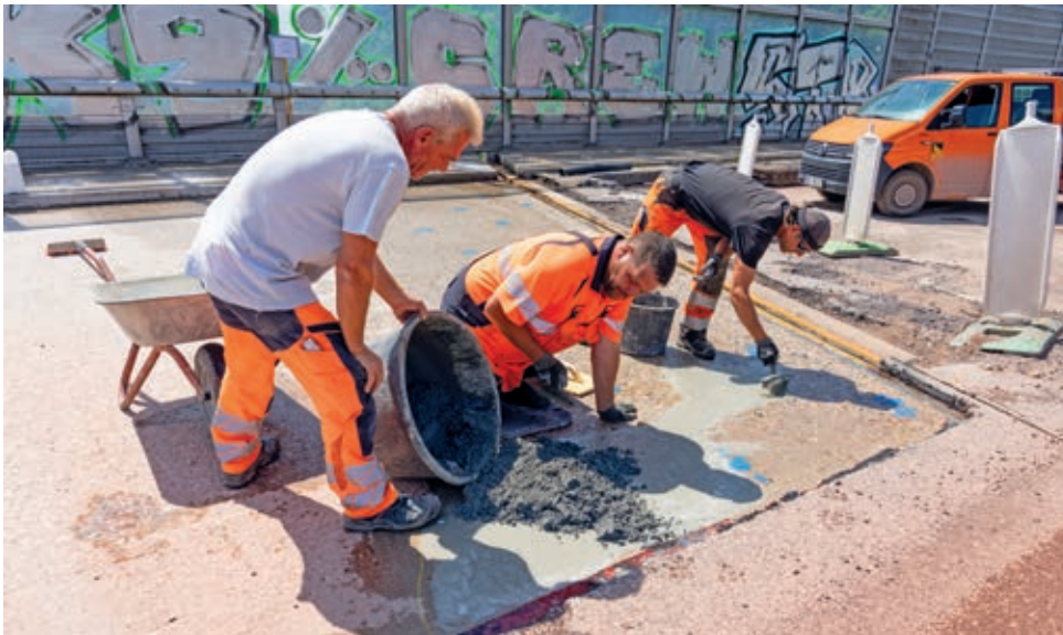
Links: Handarbeit: Die Mitarbeiter der Bauwerksinstandsetzung gleichen vor der Bauwerksabdichtung Unebenheiten des Überbaus aus.
