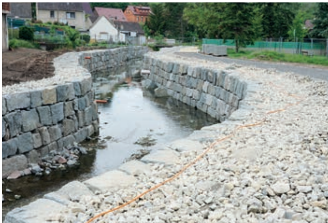
Hochwasserschutz im Kernort: Hier wurde eine Schwergewichtsmauer aus Natursteinen hergestellt.
