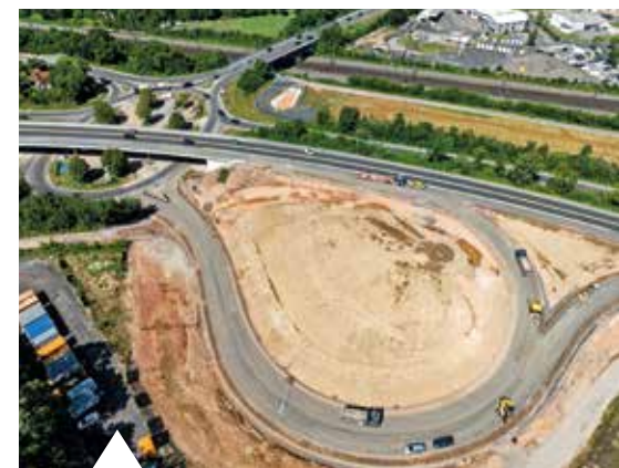
Das neue Anschlussrohr: Neben dem eigentlichen Kreisverkehr wurde eine neue Anschlussrampe hergestellt. Dadurch können Verkehrsströme getrennt werden.
