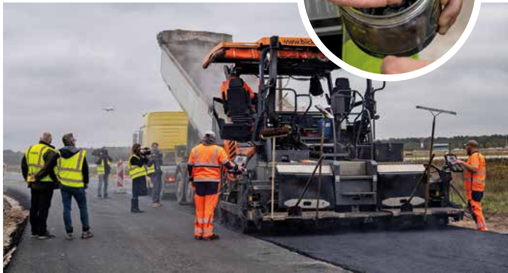
Großes Medieninteresse: Die Arbeit unseres Einbauteams an der Teststrecke für Bio-Bitumen wurde von den Kameras festgehalten.
