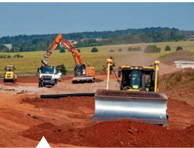
Jede Menge Bodenbewegung: Für den neuen Streckenverlauf müssen 200.000 Kubikmeter Boden bewegt werden. Ein Großteil der Strecke wird in Dammlage geführt.
