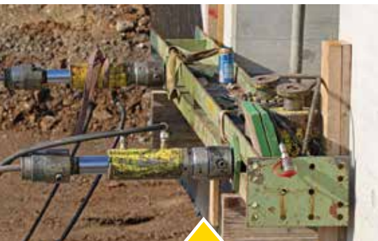
KRAFTPAKETE: Mit Hilfe dieser Litzenheber wurde der 400 Tonnen-Stahlbetonkoloss auf der Verschubbahn bewegt.
