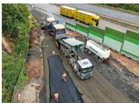
Links der Betoneinbau, rechts der Asphaltfertiger: Im November herrschte Hochbetrieb an der PWC Anlage Markwald (großes Foto).
