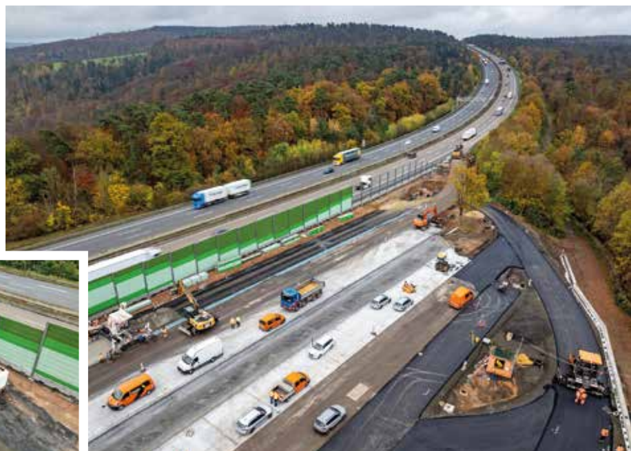
Links der Betoneinbau, rechts der Asphaltfertiger: Im November herrschte Hochbetrieb an der PWC Anlage Markwald (großes Foto).
