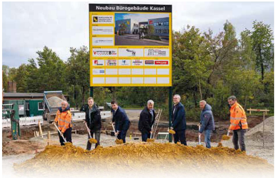
Startschuss für den Bau eines neuen Verwaltungsgebäudes an der Schenkebieber Stanne. Den ersten Spatenstich vollzogen von links: Geschäftsbereichsleiter Sven Böhme, Christian Horn, Projektleiter Fr. Richter, Matthias Nölke, Stadtkämmerer der Stadt Kassel, Jakob Volk, Geschäftsführer Fr. Richter, Vorstandsvorsitzender Frank Finster, Frank Neumann, Neumann Architektur, und Projektleiter Thorsten Kistner.
