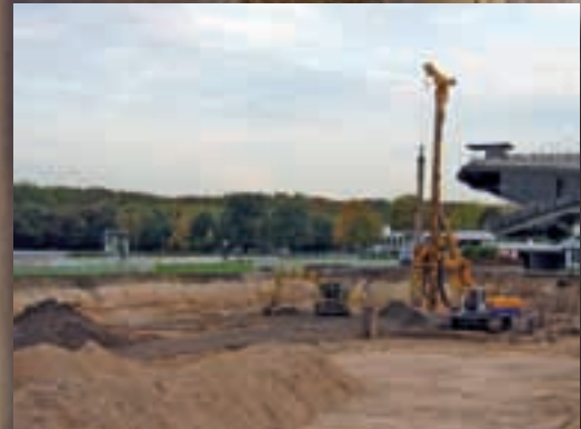
Bohrpfahlarbeiten Ø 90 cm, 800 lfdm, Längen bis 17 m, Potala Palace Hotel, Frankfurt/M.
