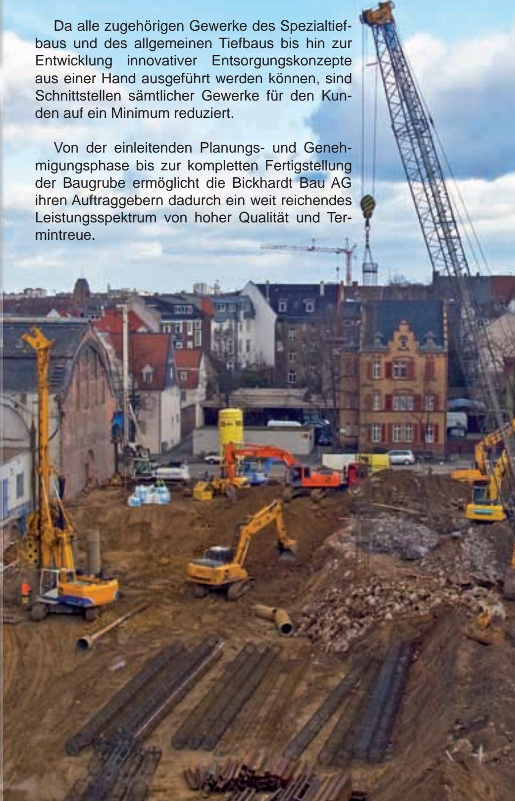
Kombinierte Bohrpfehl- und Spundwandbauweise zur Baugrubenumschließung
