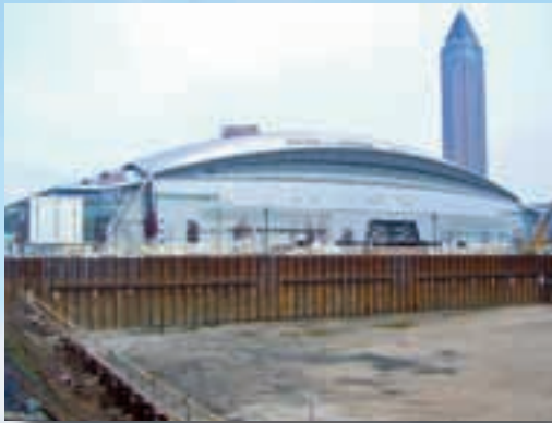
Baugrubenumschließung in Spundwandbauweise
