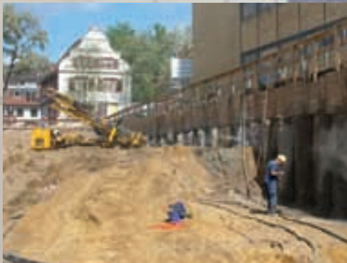
Rückverankerungsarbeiten an einer Verbauwand
