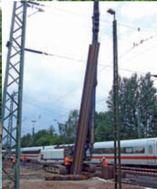
Rammarbeiten Fußgängerunterführung, München
