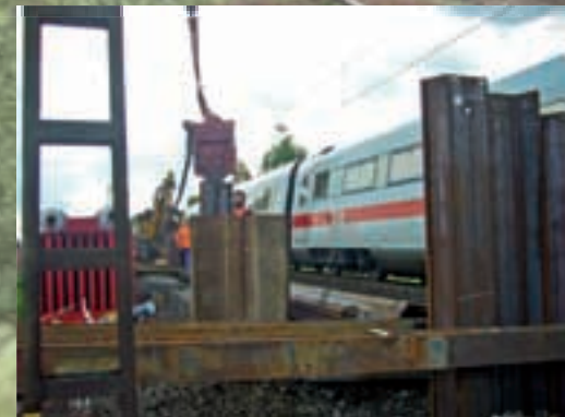
Rammarbeiten Hilfsbrückenaufleger, Fulda
