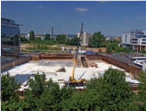
Kombinierte Bohrpfehl- und Spundwandbauweise zur Baugrubenumschließung
