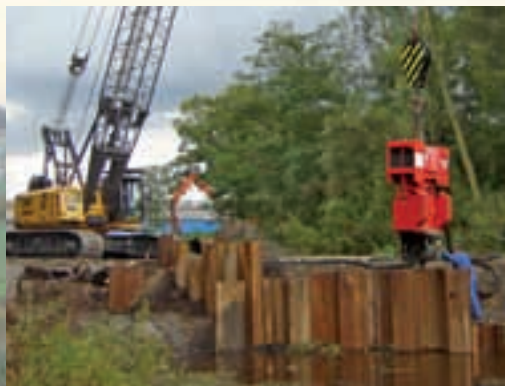
Rammarbeiten Uferbefestigung, Plauer See
