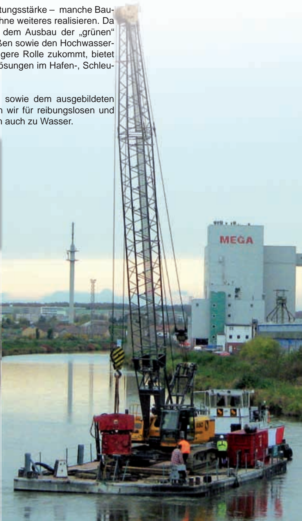
Rammarbeiten im Mittellandkanal, Haldensleben
