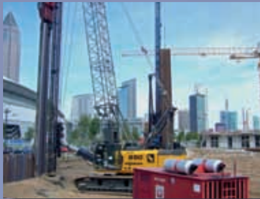
Seilbagger mit Hängemäkler im Rammeinsatz
