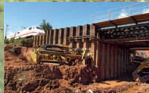
Verbau und Hilfsbrückenkonstruktion im Zuge A 66/Linienverbesserung ABS 5, Neuhof
