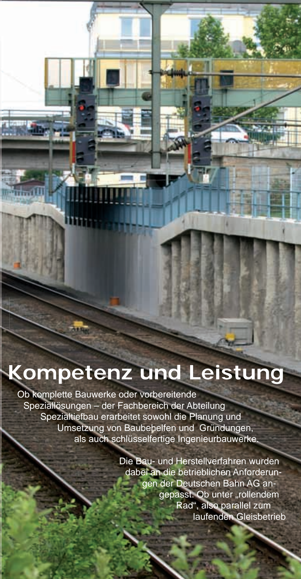
Verbau und Hilfsbrückenkonstruktion im Zuge A 66/Linienverbesserung ABS 5, Neuhof
