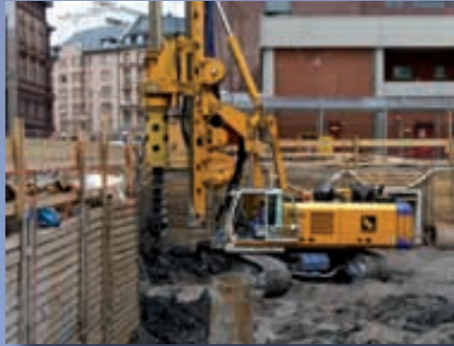
Großdrehbohranlage Bauer BG 28 H
