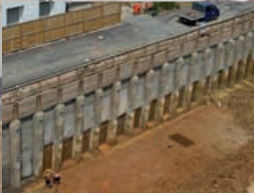
Spritzbetonarbeiten an einer aufgelösten Bohrpfehlwand
