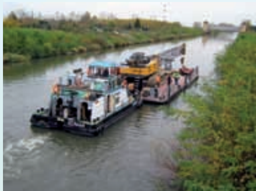
Rammarbeiten im Mittellandkanal, Haldensleben
