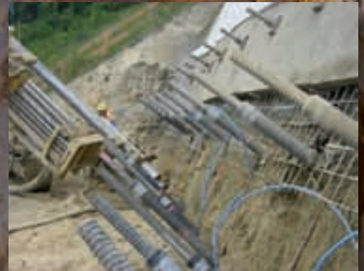
Hangsicherung mit GEWI 63,5 Verpresspfählen, Weil am Rhein, A 98
