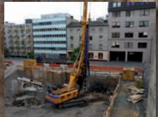
Gründungsbohrpfähle Ø 1,20 m, Längen bis 20 m, Schulgebäude Innenstadt Frankfurt/M.
